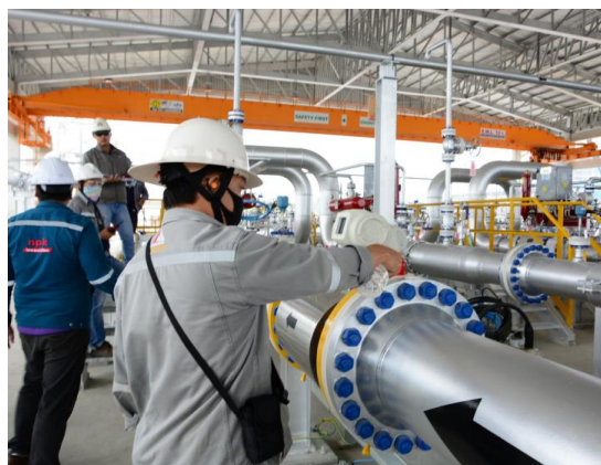
รูปที่ 3-13 การตรวจสอบการรั่วไหลของก๊าซ
